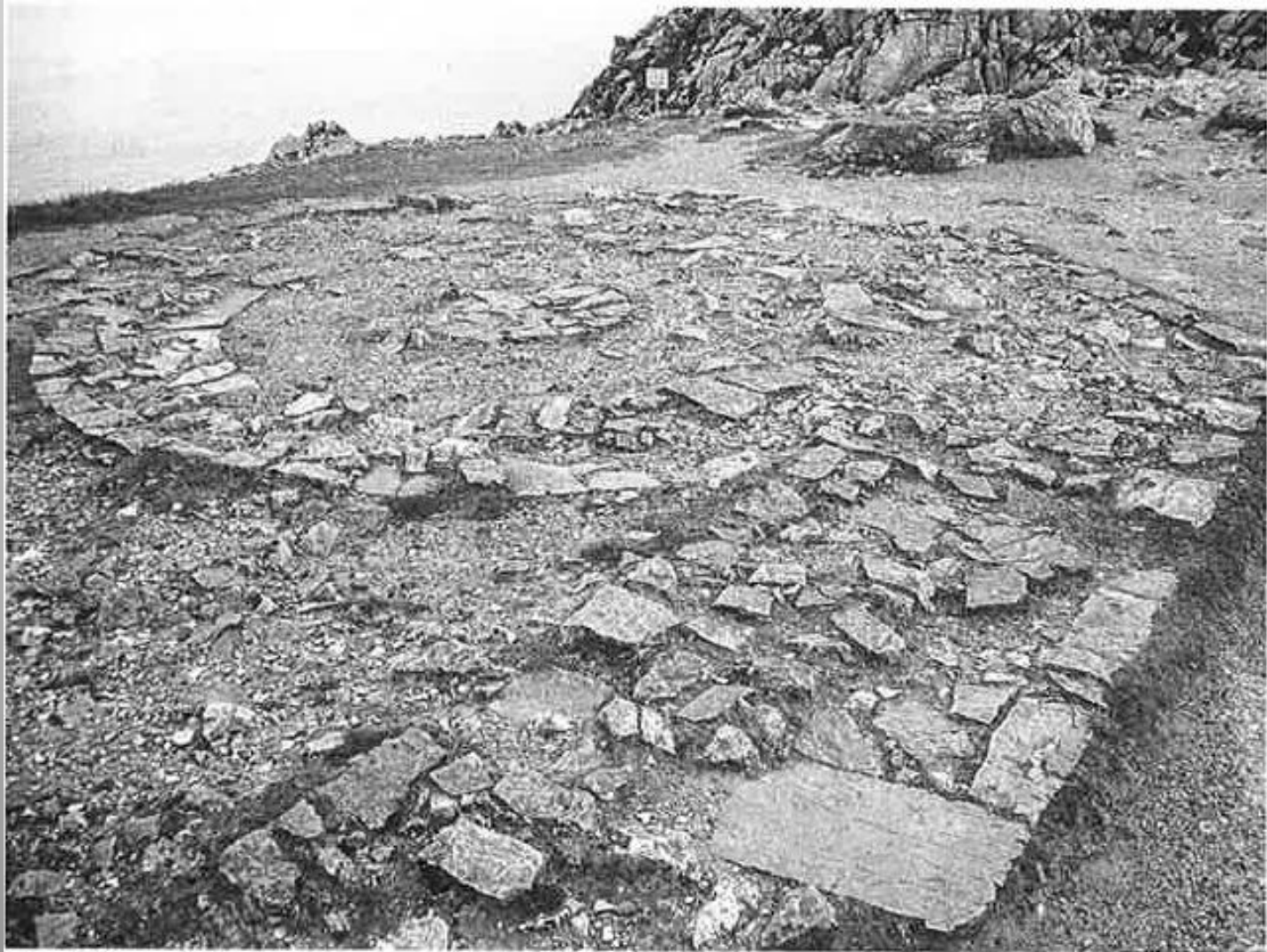
Fondations de la chambre de veille de l'électro-sémaphore de la pointe des Pois (Camaret). On remarque tout particulièrement l'emplacement du mât sémaphorique.
